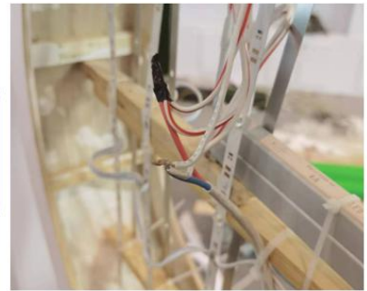
临时电线电缆、变压器直接安装于木质构建上
