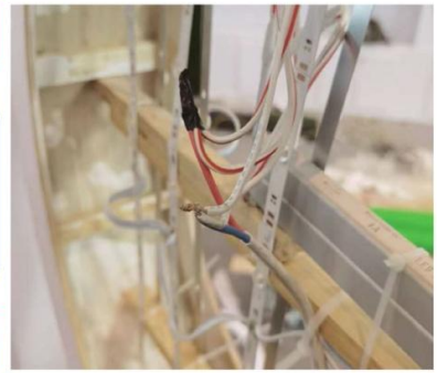
临时电线电缆、变压器直接安装于木质构建上
