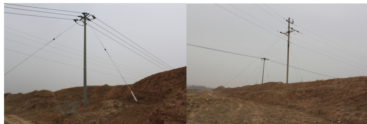
图 3-13 电线杆占压东侧墙体
